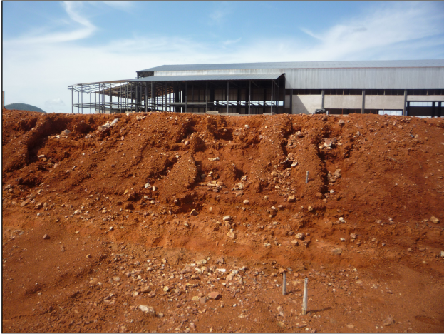
Figura 16.- Talud de una terraza afectada por la erosión (Ago 2.010)
