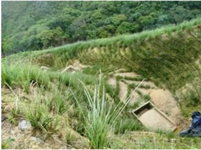
Figuras 12 y 13.- Cárcava en vías de estabilización, vistas izquierda y derecha (May 2.010)
