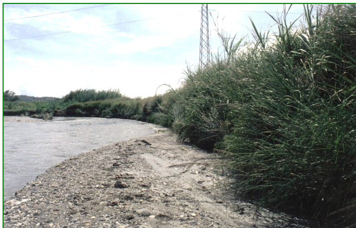
Figura 2.- Acumulación de Sedimentos en la orilla que antes erosionaba Río Turbio, cerca de Yaritagua, Edo. Yaracuy.
