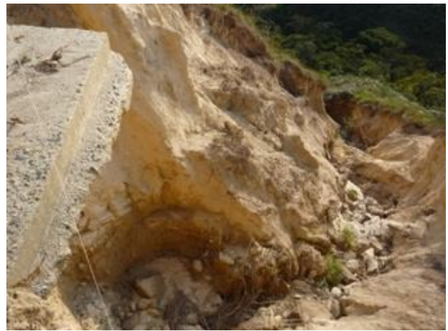
Figura 9.- Vista izquierda de la cárcava (Enero 2.009)*
