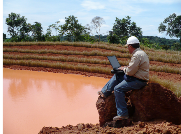
Figura 7.- Laguna protegida con vetiver (Jun 2.005)
