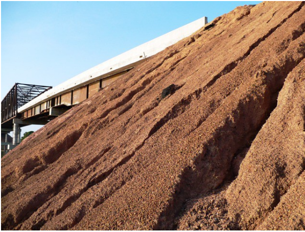
Figura 3.- Talud Sur del Puente Capanaparo antes de la siembra (Diciembre 2007)
