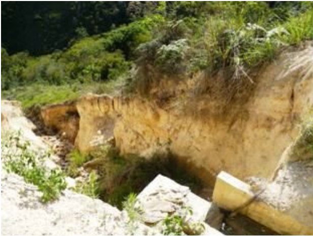
Figura 8.- Vista derecha de la Cárcava (Enero 2.009)
