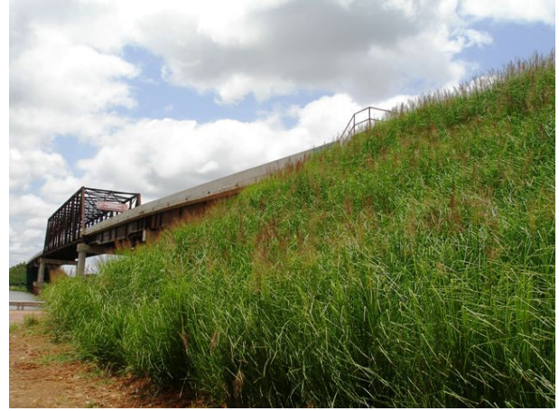
Figura 4.- mismo talud estabilizado con Vetiver (Junio 2008)
