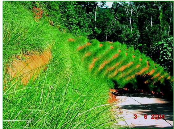
Figura 5 Talud ya estabilizado con vetiver (Jun 2.004)
